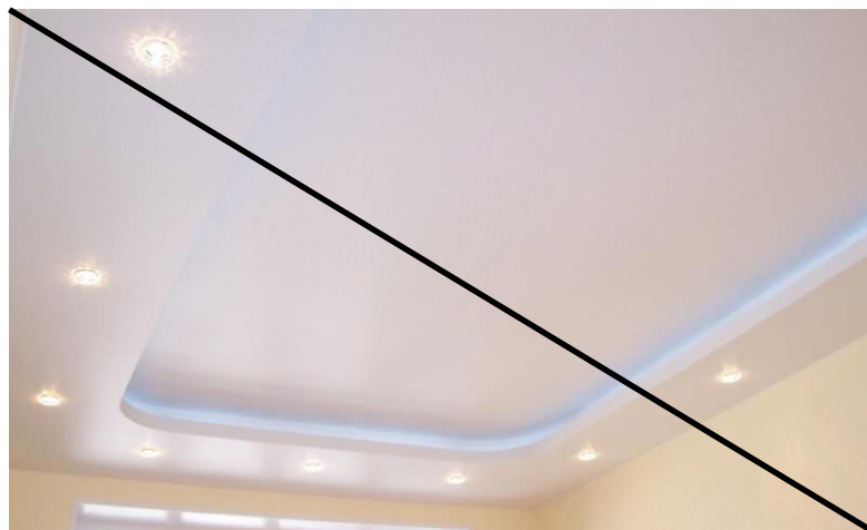
Плохо Многоуровневые гипсокартонные конструкции
